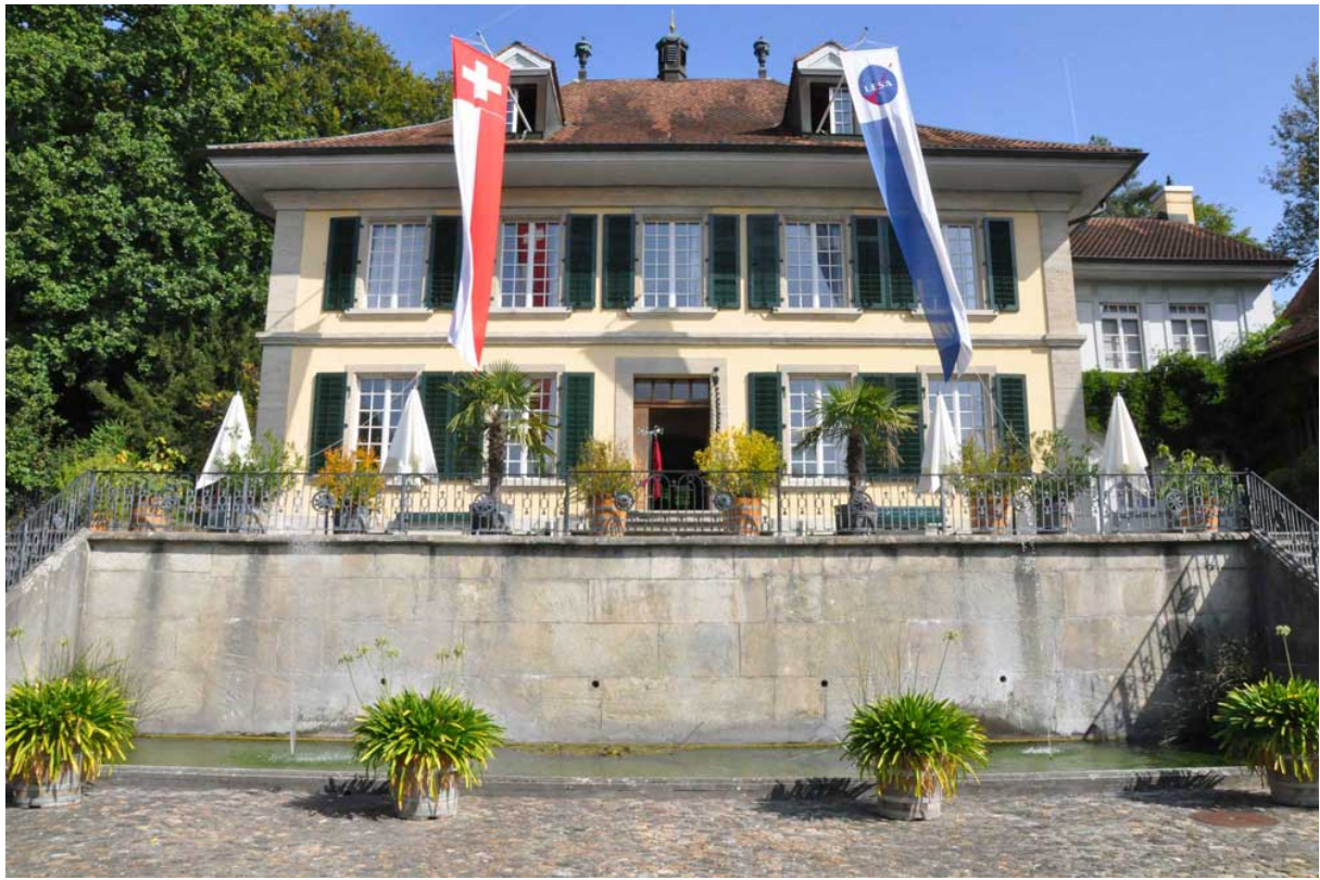
Das feierlich beflaggte Burghaldenhaus in Lenzburg ist nun offiziell auch Sitz der LESA.
